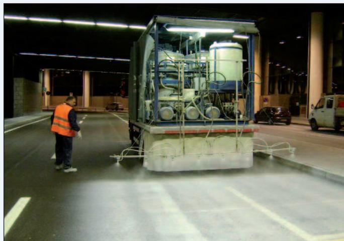
Figura 4 - La macchina spruzzatrice nella fase di spruzzatura a freddo sulla pavimentazione già esistente
